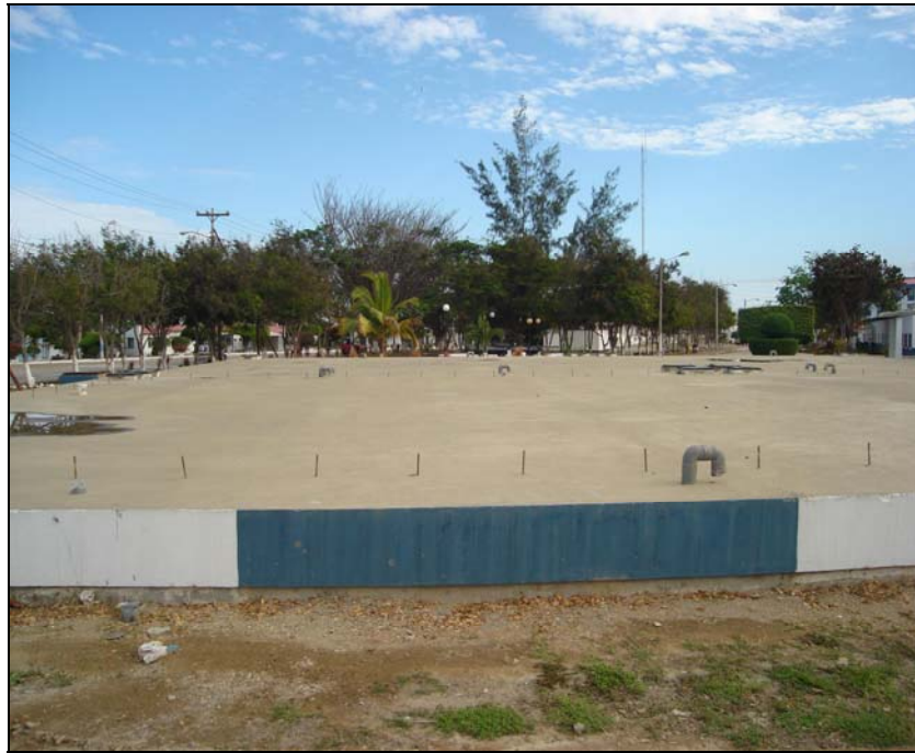
Figura. 3.21 RECORRIDO DE LA OBRA CIVIL DE LA CISTERNA PRINCIPAL
