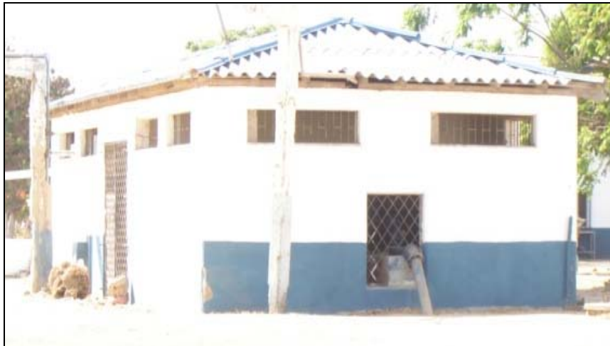
Figura. 3.17 VISTA EXTERIOR DEL CUARTO DE BOMBAS
