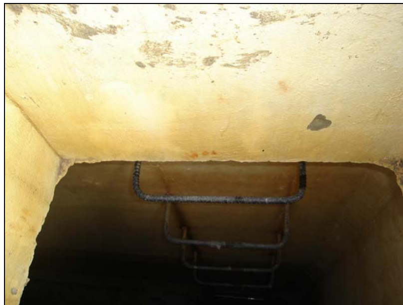
Figura. 3.4 INSPECCION INTERNA DE CISTERNA PRINCIPAL DE ALMACENAMIENTO DE AGUA
