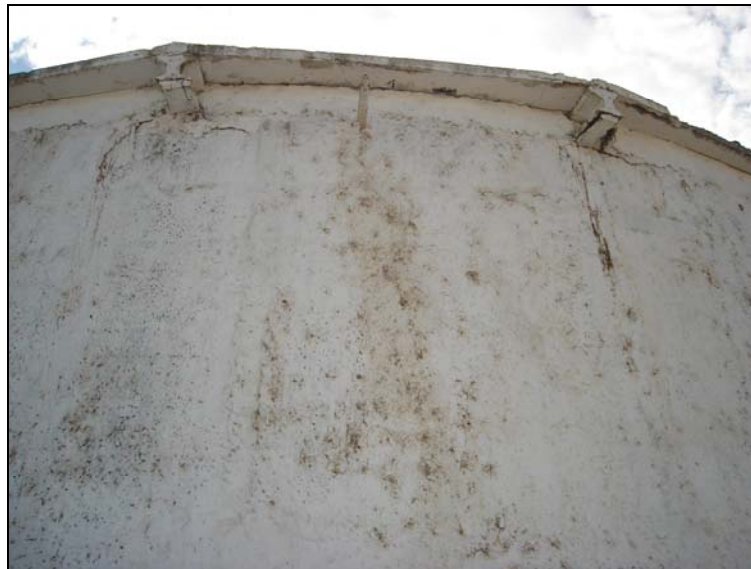
Figura 3.24 RECORRIDO DE LA OBRA CIVIL DE LOS TANQUES CIRCULARES DE CONCRETO
