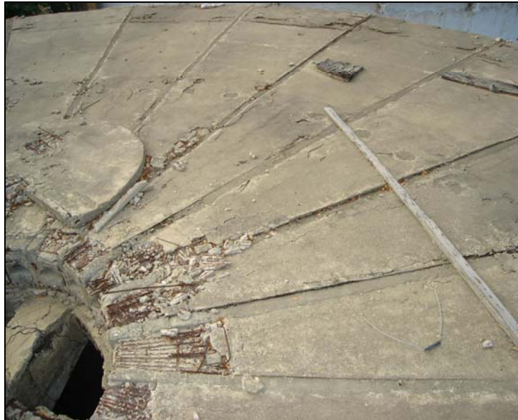
Figura 3.23 RECORRIDO DE LA OBRA CIVIL DE LOS TANQUES CIRCULARES DE CONCRETO
