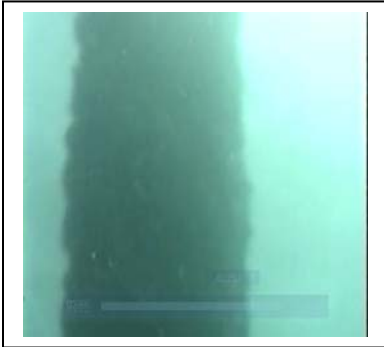
Estado estructura concreto bajo el mar
