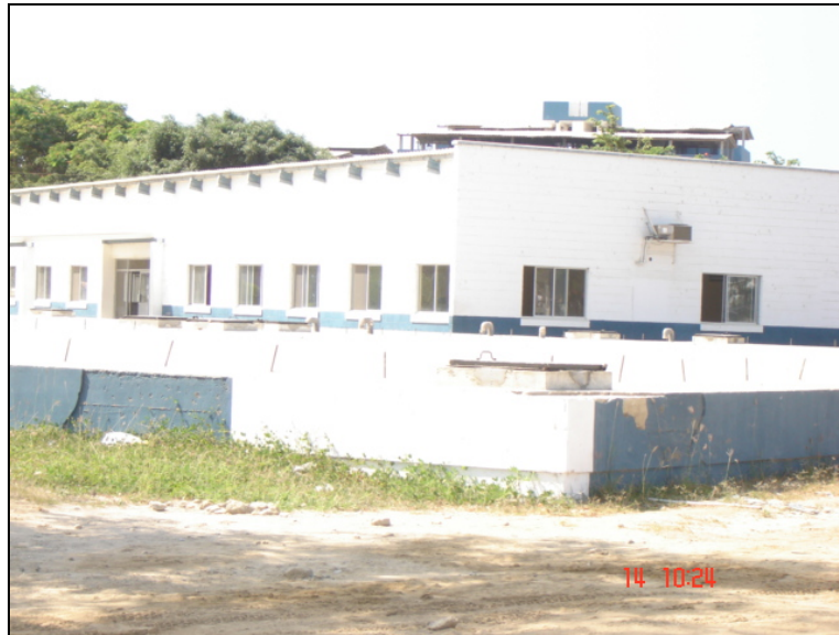
Figura. 3.1 CISTERNA PRINCIPAL DE ALMACENAMIENTO DE AGUA
