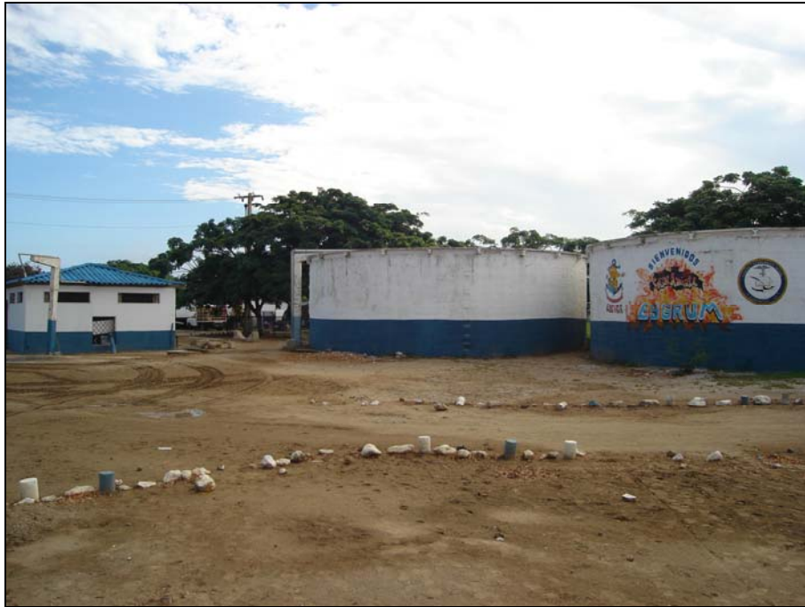
Figura. 3.8 TANQUES DE ALMACENAMIENTO CIRCULARES DE CONCRETO
