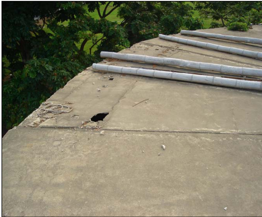
Figura 3.22 RECORRIDO DE LA OBRA CIVIL DE LOS TANQUES CIRCULARES DE CONCRETO
