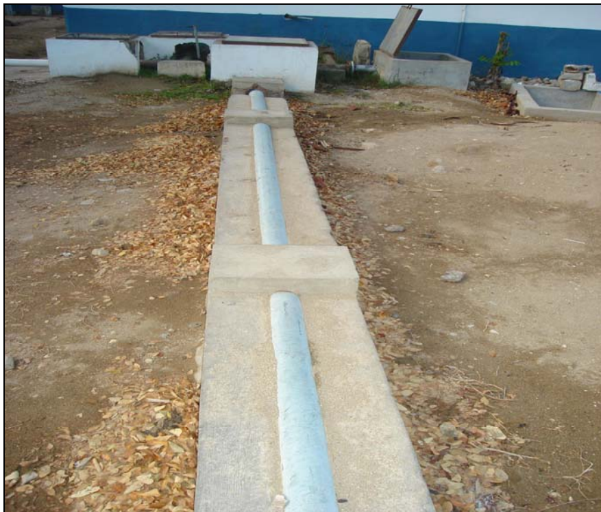
Figura. 3.14 TUBERIA DE PVC DE 4 PULGADAS A LA SALIDA DE LA CISTERNA HACIA EL CUARTO DE BOMBAS
