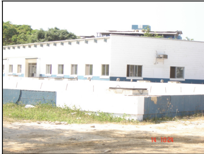
Figura. 1.12 CISTERNA PRINCIPAL Y VALVULAS PRINCIPALES
