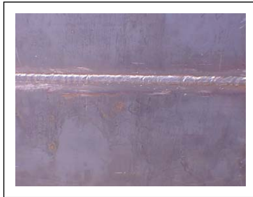
FOTO 3.5 CARA DE LA SOLDADURA GMAW METAL BASE ACERO ASTM A36
