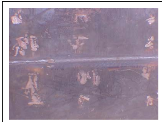
FOTO 3.6 RAÍZ DE LA SOLDADURA GMAW METAL BASE ACERO ASTM A36
