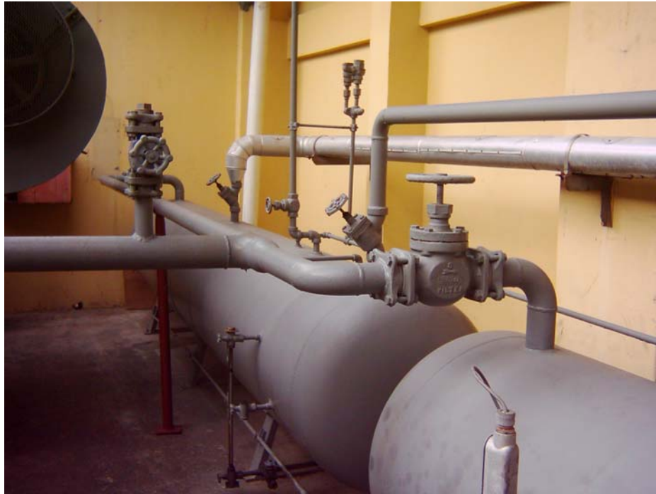
Figura 1.7 Recibidores de refrigerante líquido
