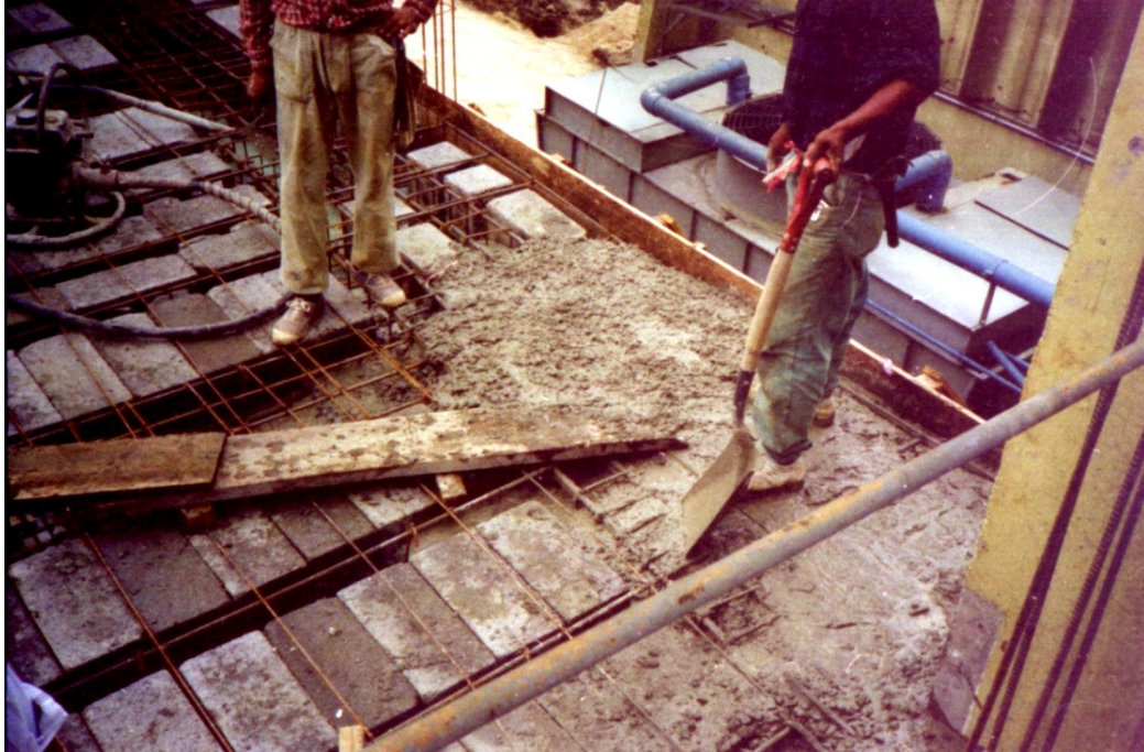
Figura 2.5. Fundición de losa para Condensador Evaporativo
