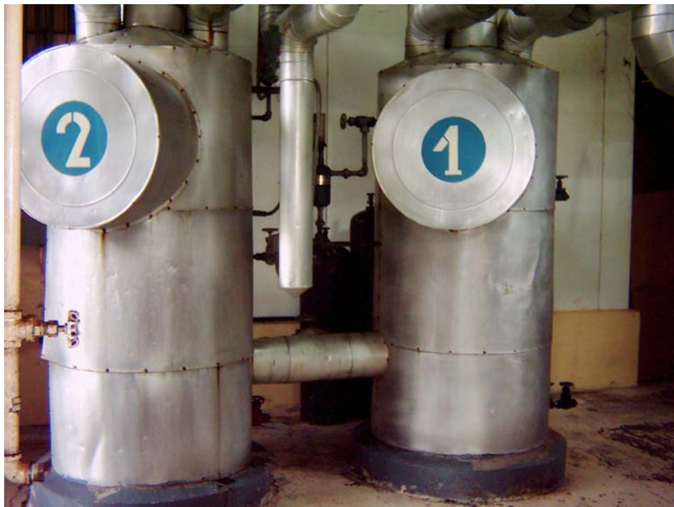
Figura 1.3 Trampas de Succión
