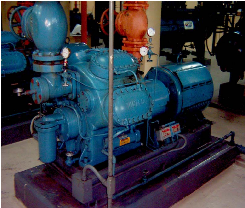
Figura 1.5 Compresor recíprocante VMC-448
