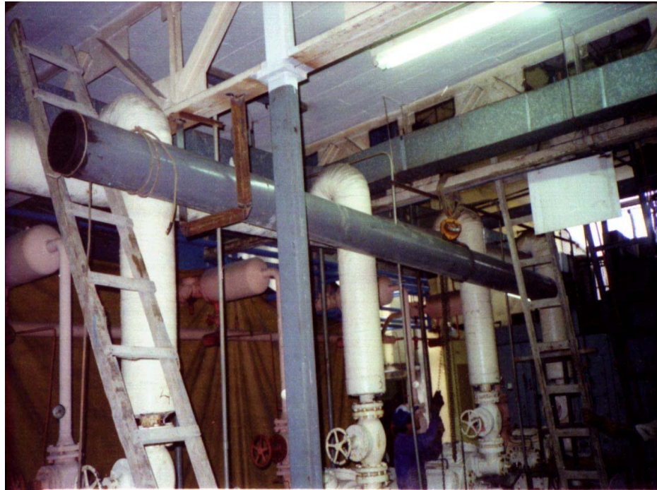
Figura 2.6 Instalación de Tuberías
