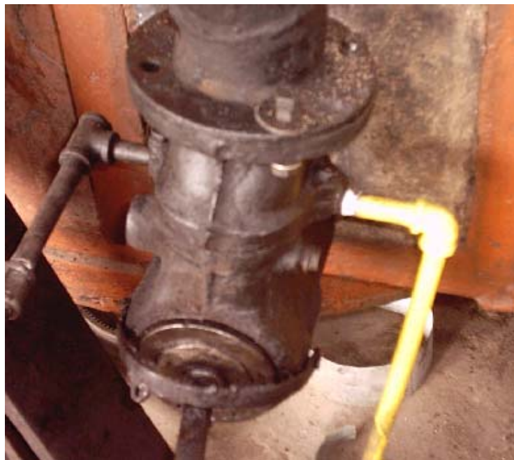
Foto 2: Mejoramiento del quemador
