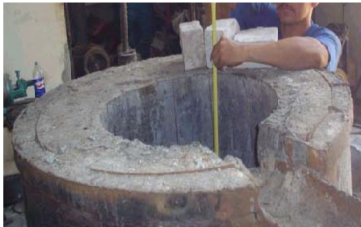
Foto 1: Colocación de los ladrillos refractarios
