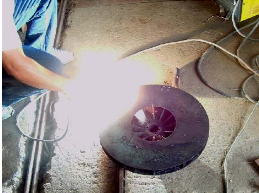
Foto 6: Construcción del impulsor
