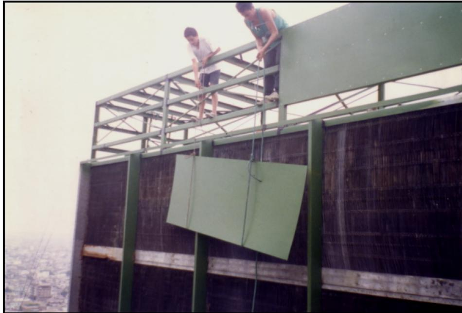
**Figura 2.3.** ARMADA PLENUM Y ESTRUCTURA BASE PARA VENTILADORES
