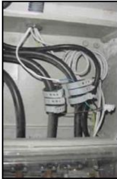
Figura 3-25 Acople inductivo para baja tensión [36]
