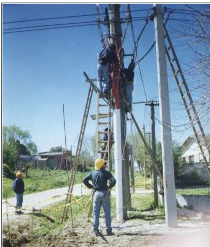
Figura 2-6 Líneas de media tensión [17]
