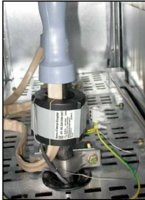
Figura 3-18 Acoplador inductivo para una línea de 300A(máx) [35]
