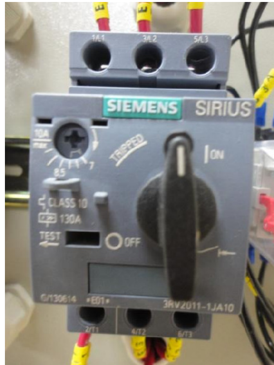
Figura 11.7: Relé térmico con un ajuste de interrupción en 7A.
