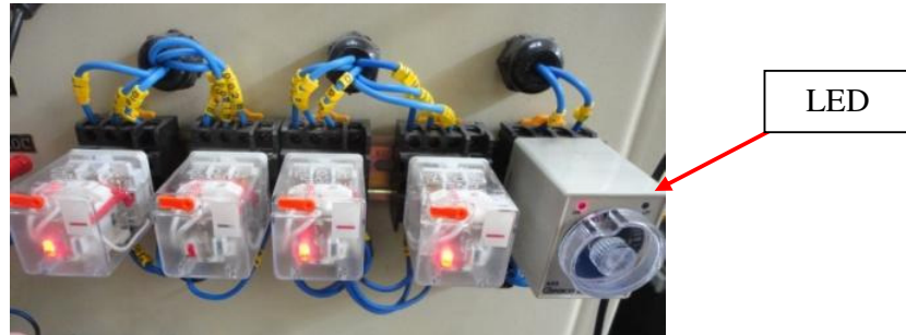
Figura 10.134: Estado de los relés luego del accionamiento del selector MANUAL/AUTO.
