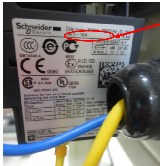
Figura 10.10: Información técnica del relé térmico.
