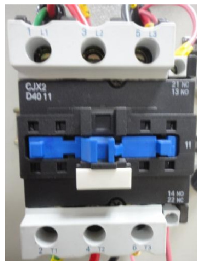
Figura 7.5: Contactor principal ó de alimentación de 40A.
