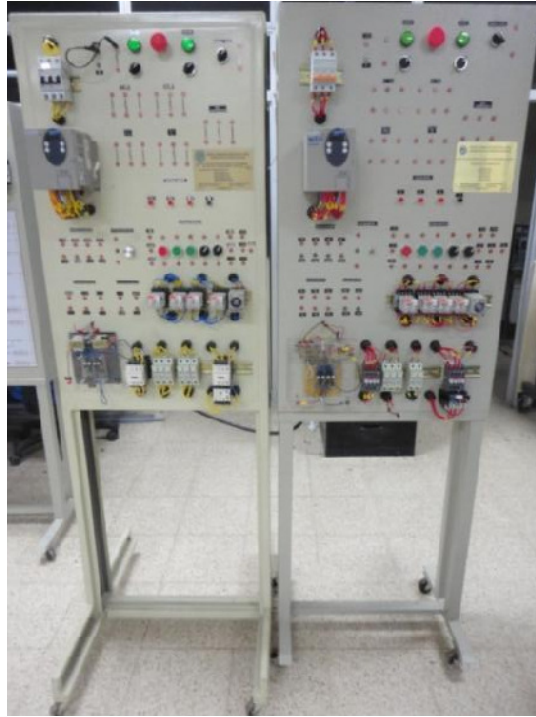
Figura 10.1: Paneles eléctricos Altivar: original (izquierda) y réplica (derecha).
