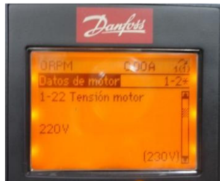
Figura 11.32: Configuración del parámetro 1-22 Tensión motor [KW].
