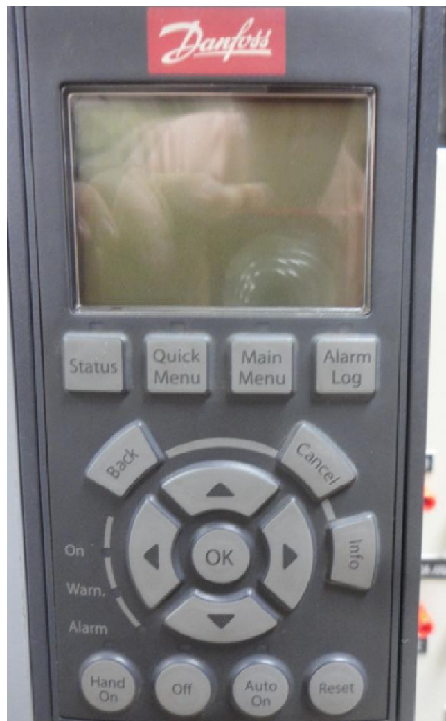
Figura 11.18: Botoneras del drive Danfoss y la interfaz de programación.
