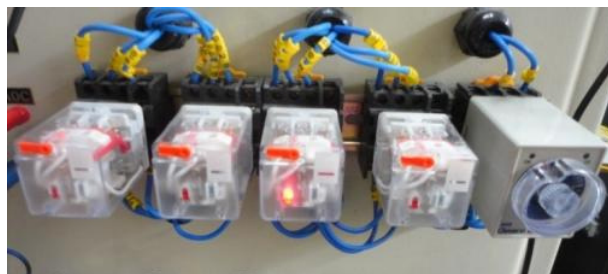
Figura 10.133: Estado de los relés previo al accionamiento del selector MANUAL/AUTO.
