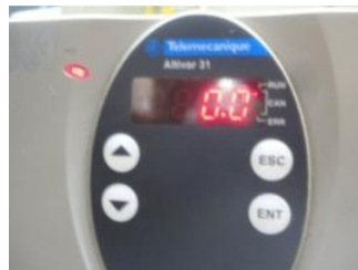
Figura 10.62: Interfaz del drive indicando el valor cero correspondiente a la mínima referencia de frecuencia.
