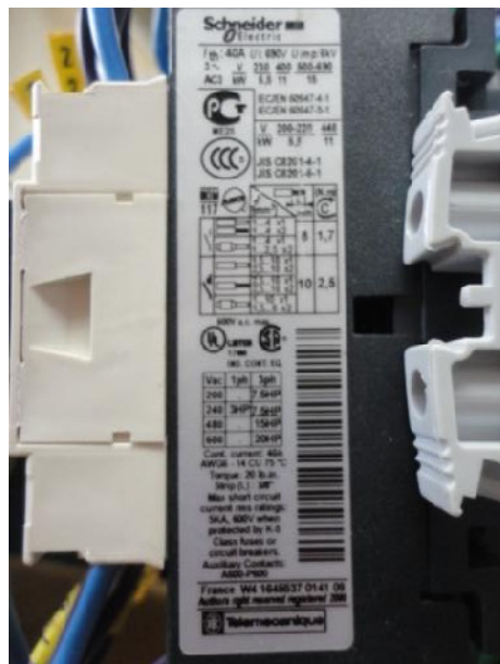
Figura 5.6: Información del contactor de 10A.
