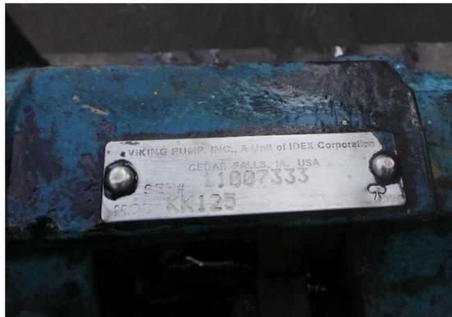
**Placa de la bomba de Fuel Oil de la planta**
