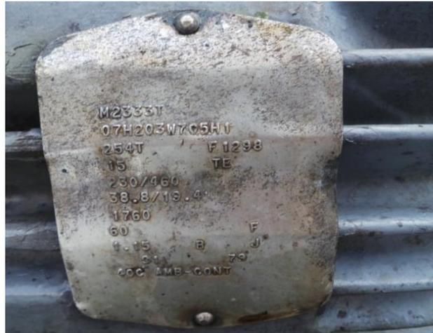
**Placa del motor de la bomba de Fuel Oil de la planta.**
