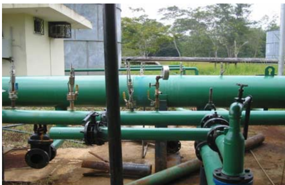
FIGURA 19: Colocación de Porta cupones en las tuberías
