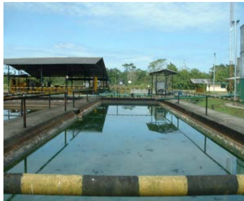
FIGURA 6: Piscina de Almacenamiento
