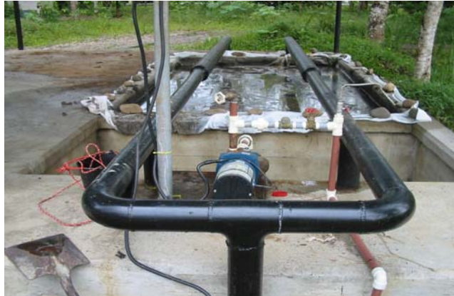
FIGURA 28: Fotografía de una Piscina de Sólidos.
