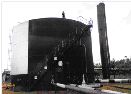
Figura 5: Tanque de Lavado.
