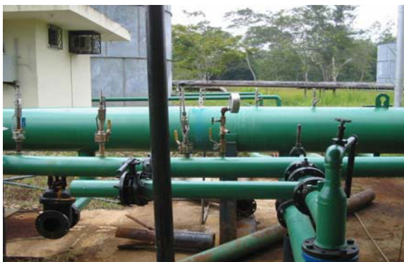
FIGURA 19: Colocación de Porta cupones en las tuberías
