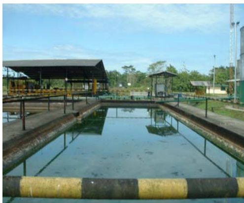
FIGURA 6: Piscina de Almacenamiento
