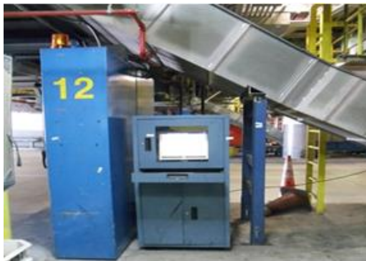
FIGURA.73 Workstation para operación INTER en BSR
