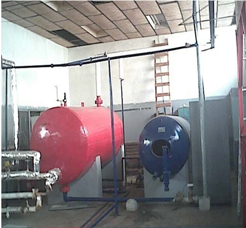
Figura 3.3 : Circuito de ingreso del agua de alimentación 1.
