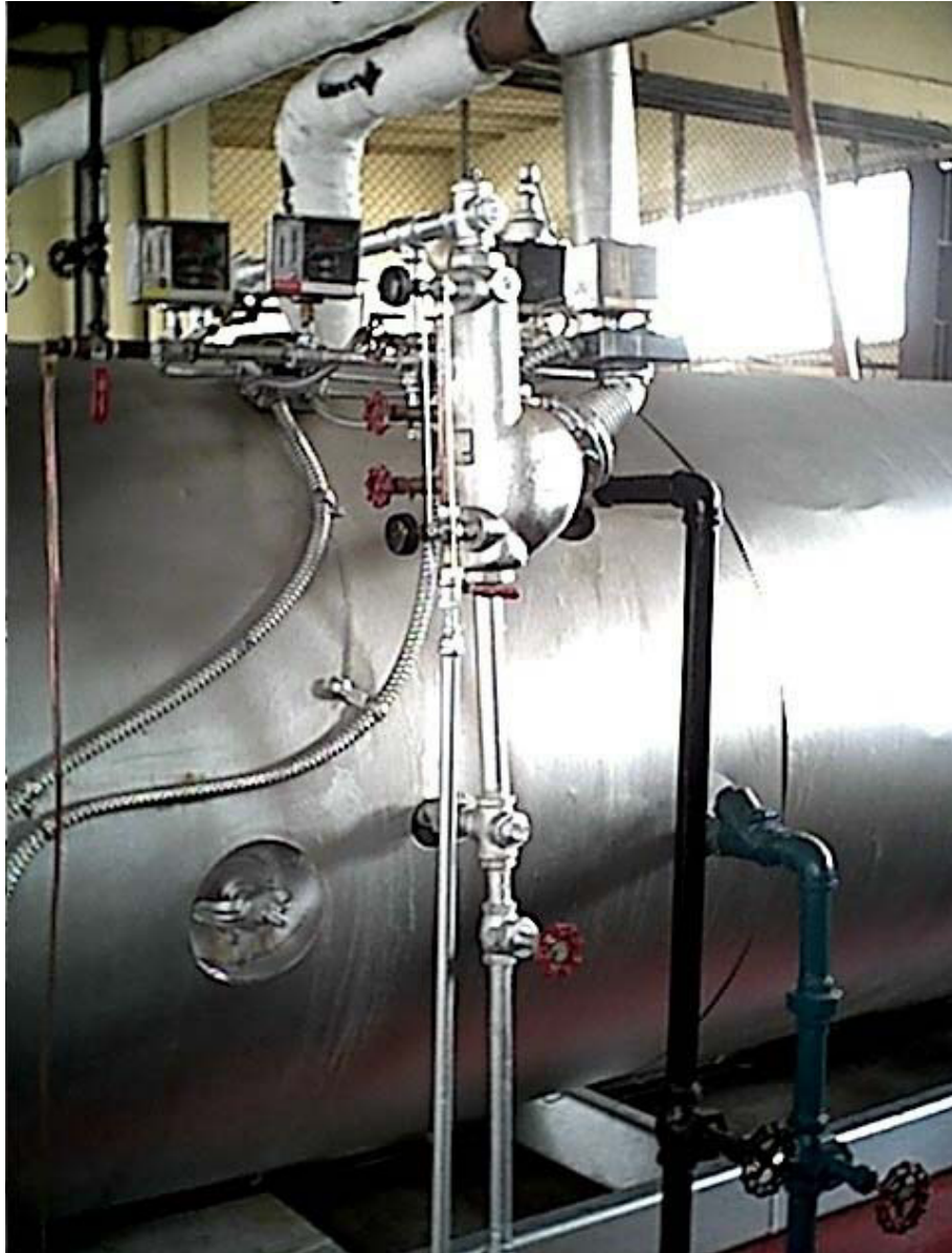
Figura 5.2 : Control de bajo nivel de agua con interruptor y alarma McDonnell tipo No. 150.
