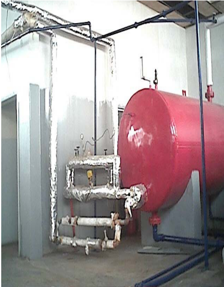
Figura 3.4 : Circuito de ingreso del agua de alimentación 2.
