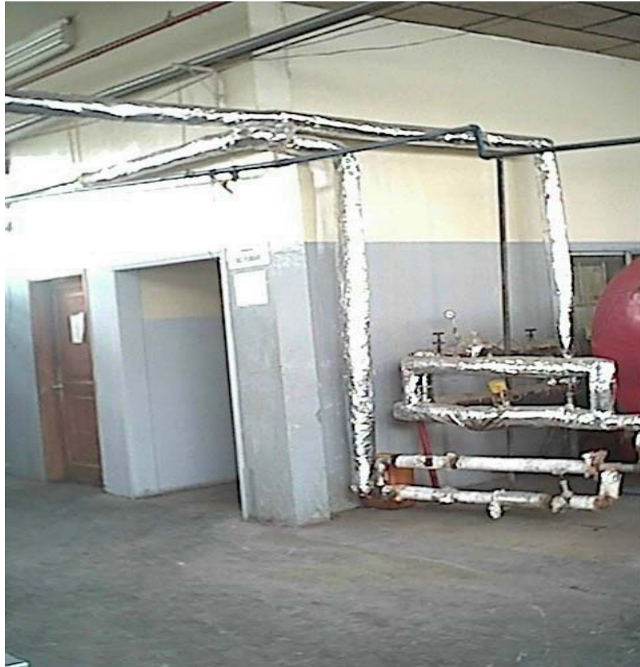
Figura 3.5 : Circuito de ingreso del agua de alimentación 3.
