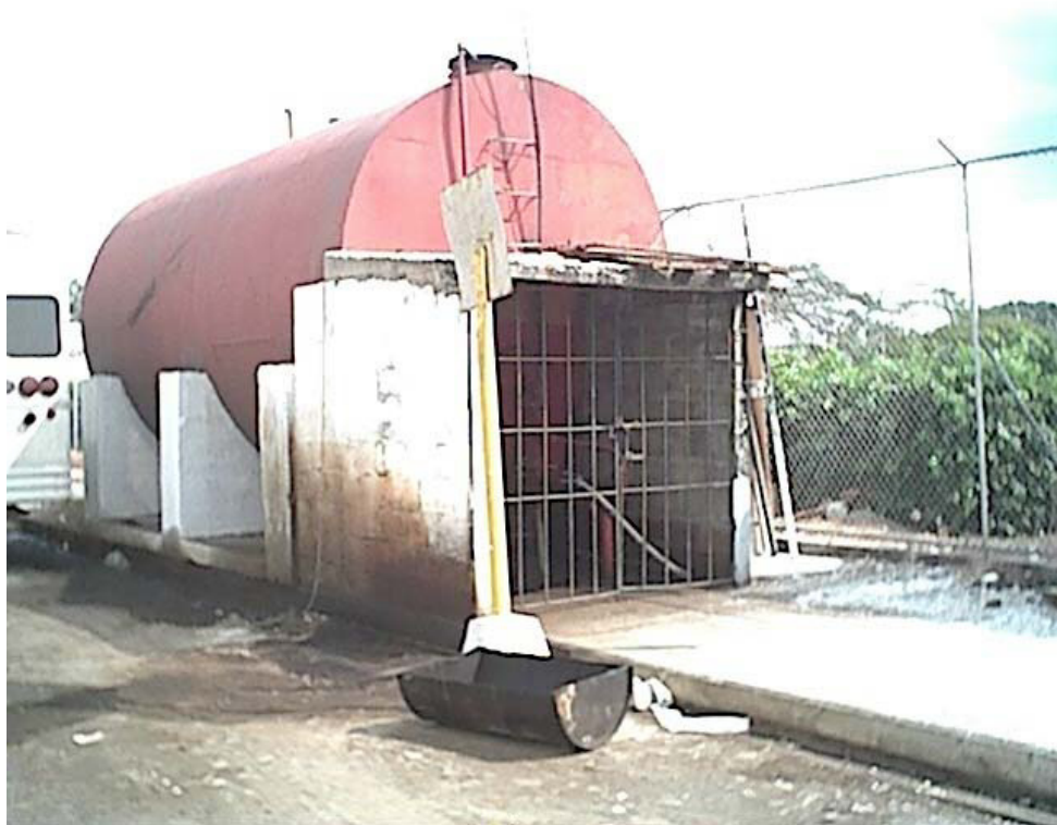
Figura 4.1 Tanque de almacenamiento del combustible.
