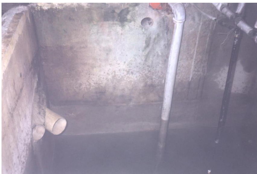
Figura 1.9 Interior de la cisterna de enfriamiento
