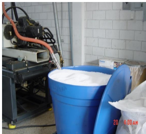
Figura 2.4: tanque de almacenamiento con material
