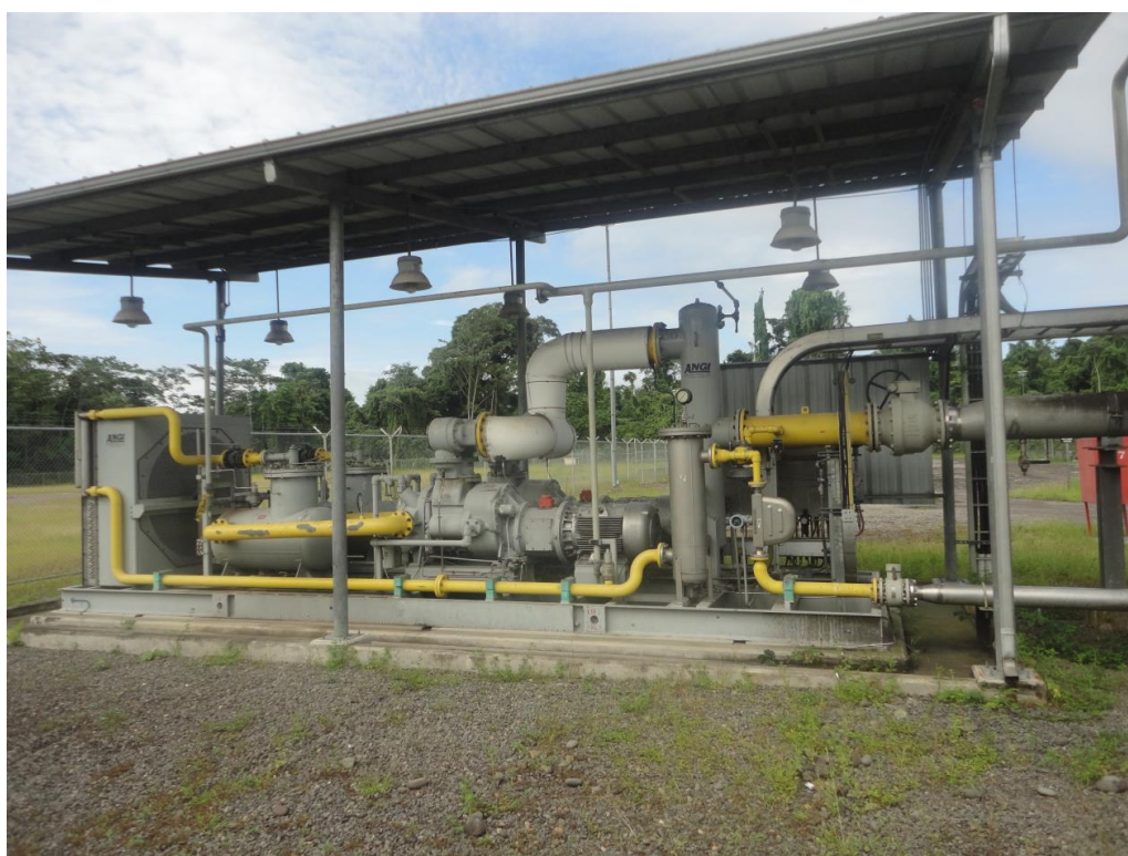
Figura 3.12: Unidad de Recuperación de Vapor. Fuente: Registro Fotográfico Campo Palo Azul Bloque 18.
