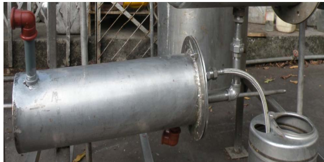
Figura 3.8 Enfriador de producto de cola
