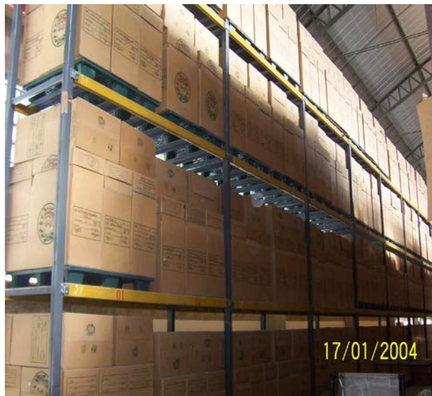
Figura 4.23 Perchas de Almacenamiento
