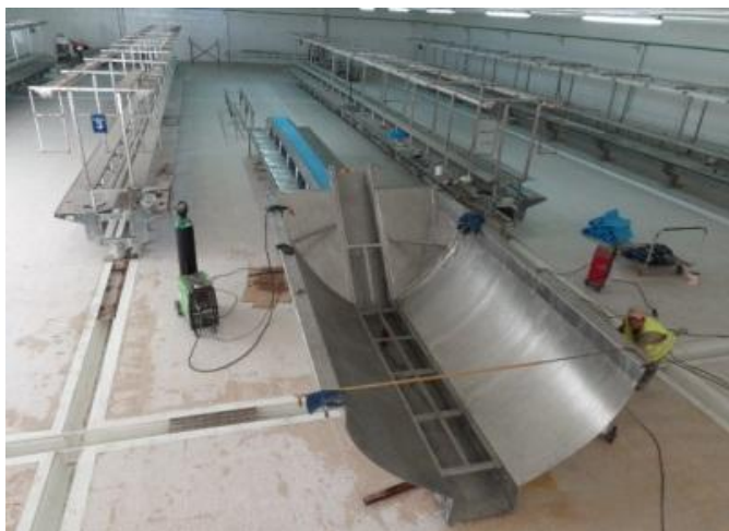
Figura 3.5: Tina de recepción de pesca en construcción
