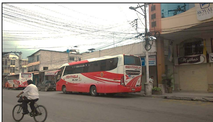
Figura 1.10: Cableado holgado cerca de un transporte interprovincial, calle Junín entre Sucre y Olmedo.
