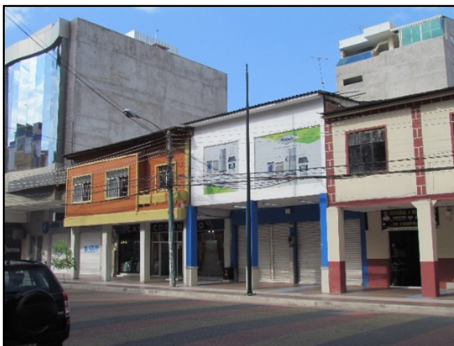
Figura 1.3: Zona mixta. Av. 25 de Junio, entre las calles Buenavista y Colón.
