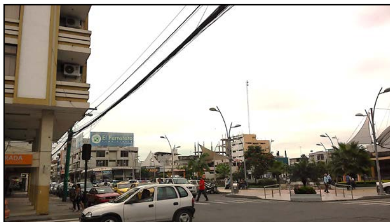
Figura 3.37: Fotografía tomada en la Calle Buenavista y Olmedo, frente a la Plaza Colón; se aprecia el empaquetamiento de cables por parte de la empresa TELCONET.
