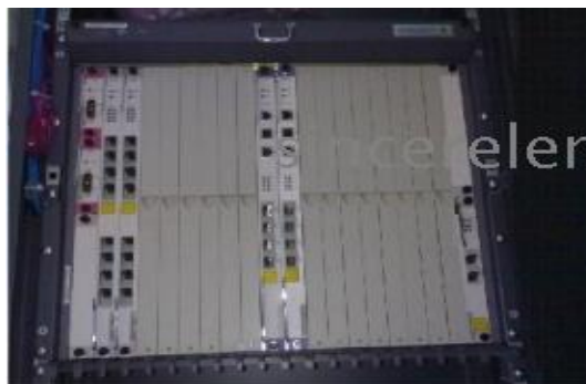
Figura 3.2 OLT para la red EPON [19]
