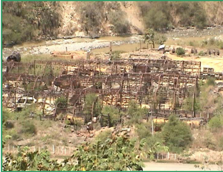
Foto 6: Instalaciones de la planta antiguas.
