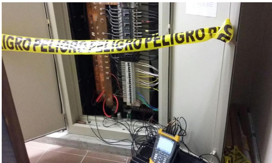
**Figura 3 Medición en las celdas de acondicionadores de aire conservando la zona de seguridad**
