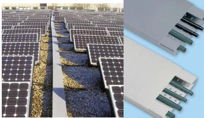
**Figura 3.83: Canaletas para instalación fotovoltaica [46]**
