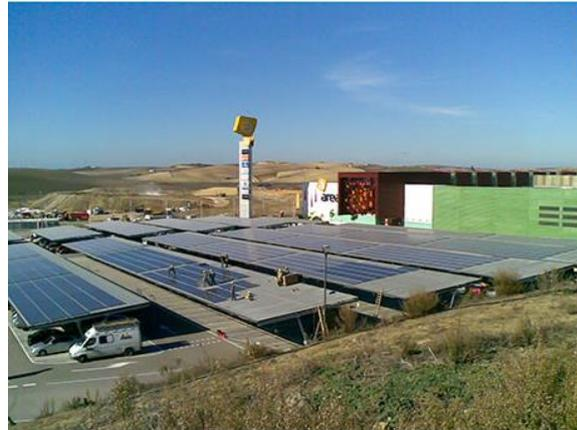
**Figura 2.5: Instalación de un sistema fotovoltaico en estructura techada**
