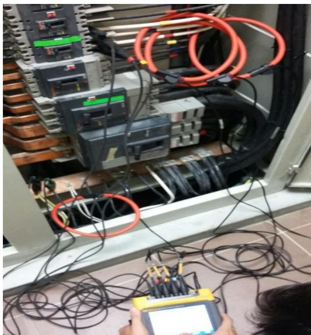
**Figura 2: Medición para el alumbrado de planta baja del edificio**
