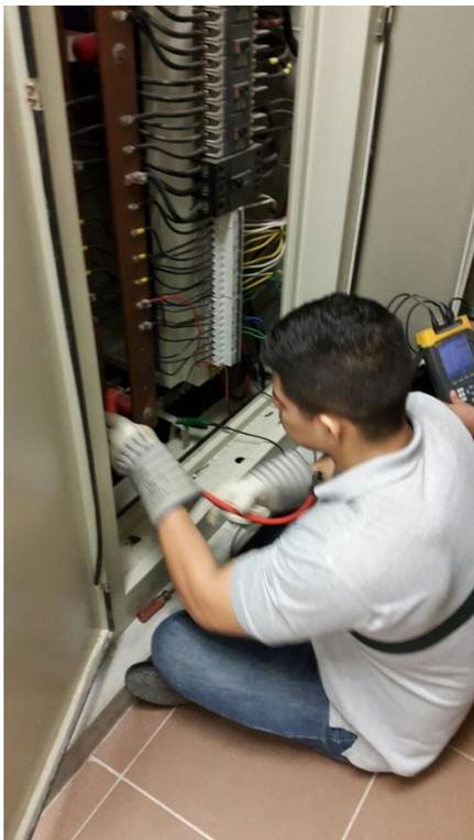
**Figura 1: Instalación del equipo de medición en las celdas del cuarto eléctrico del edificio**
