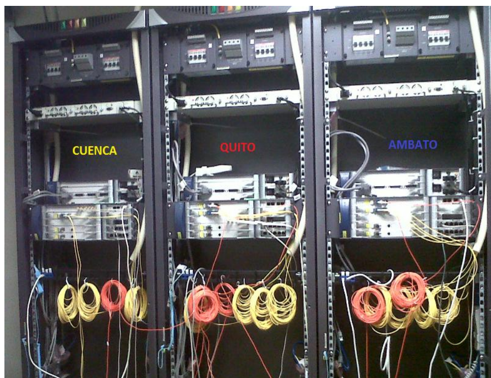
Figura 3.2 Conexiones de los equipos Huawei (Optix OSN 1500)
