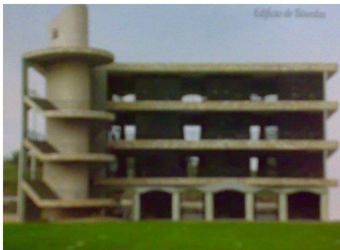
Figura 1: Edificio de Bóvedas
