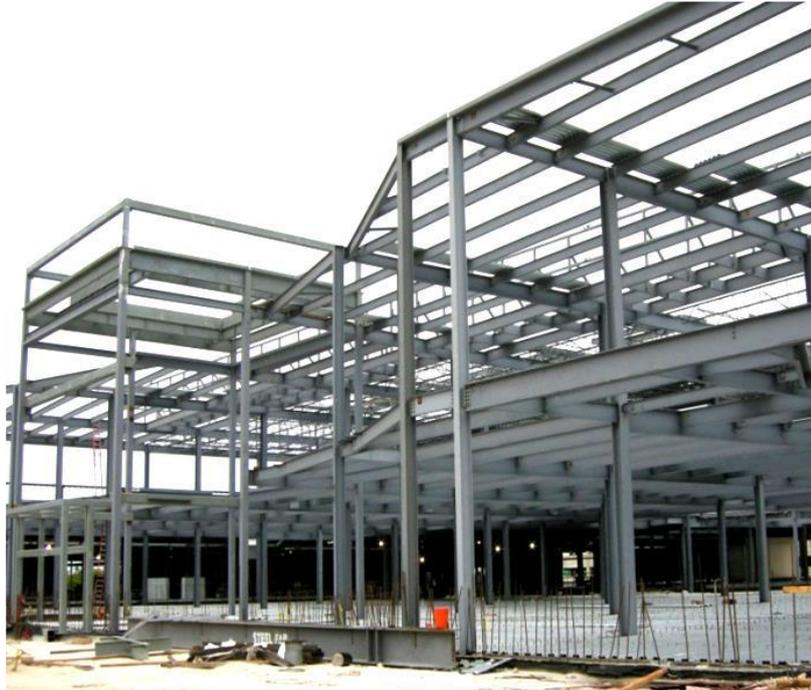
**Figura 2.1.** Pórtico Resistente a momento de centro comercial
