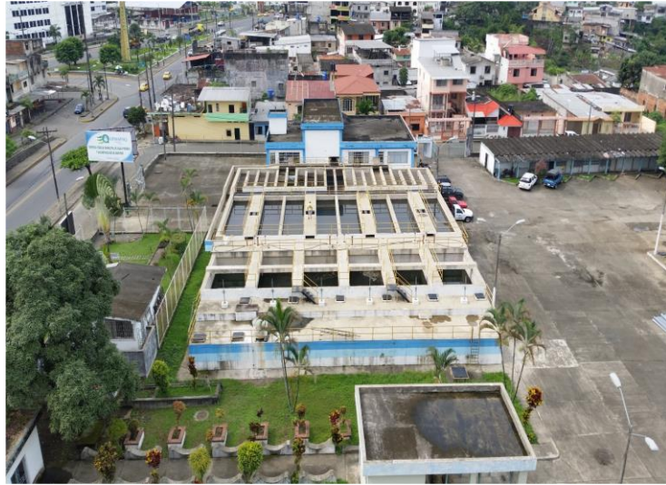
Figura 1.5 Planta de tratamiento Agua Superficiales
