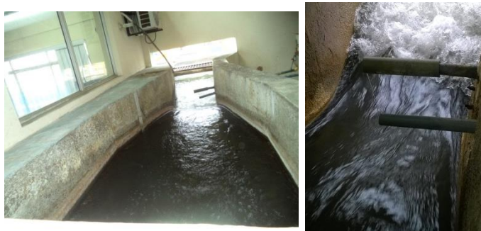
Figura 1.7 Canaleta Parshall
