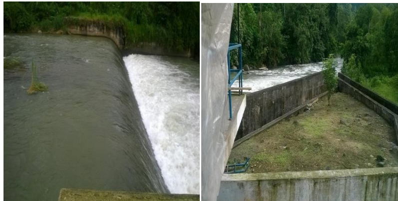
Figura 1.1 Rio Galope y Construcción
