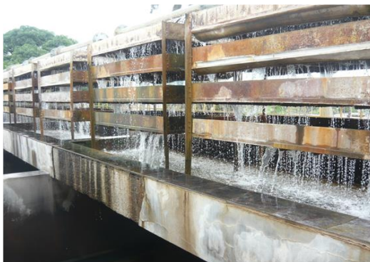
Figura 2.3 Bandejas de aireación
