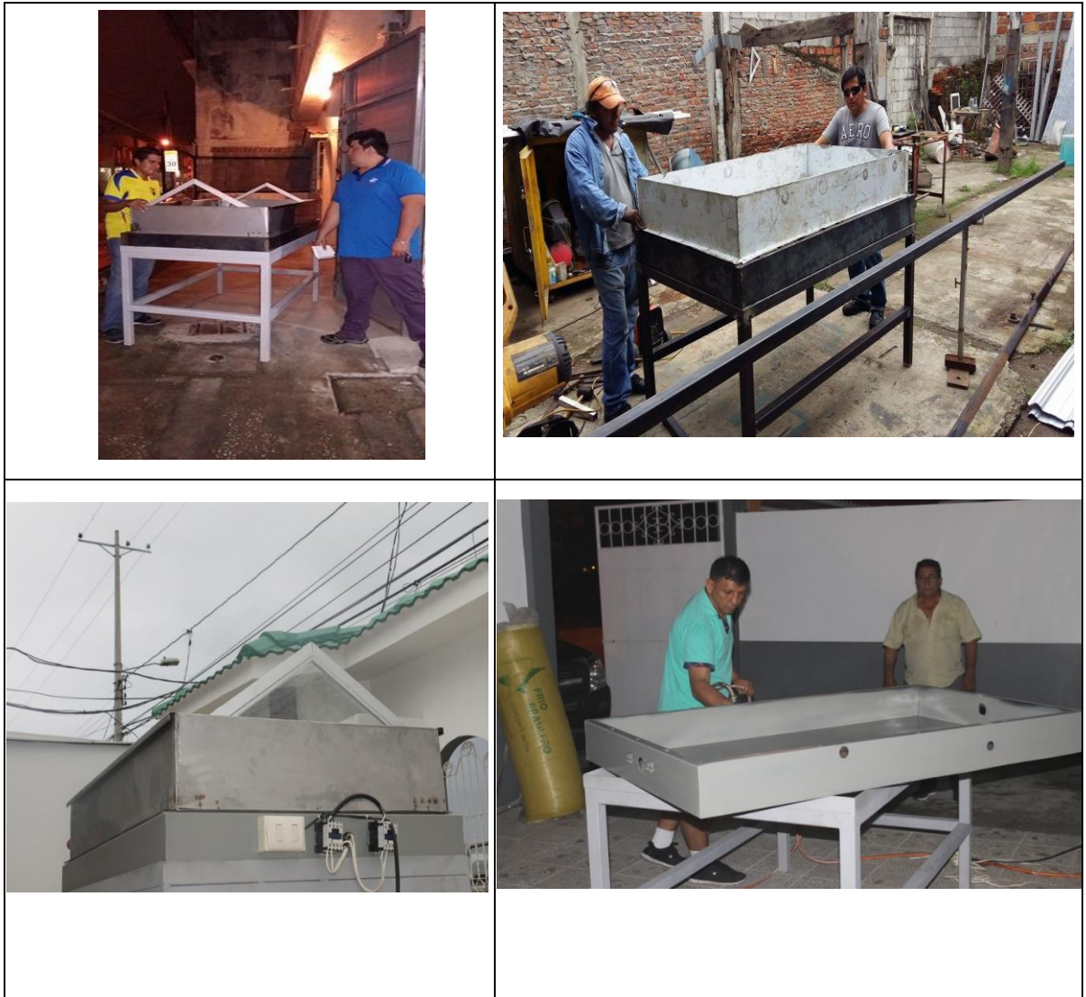
Figura 2.8. Construcción del desalinizador
