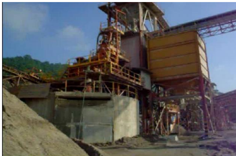
Figura 1.4 Vista de una planta de lavado de áridos
