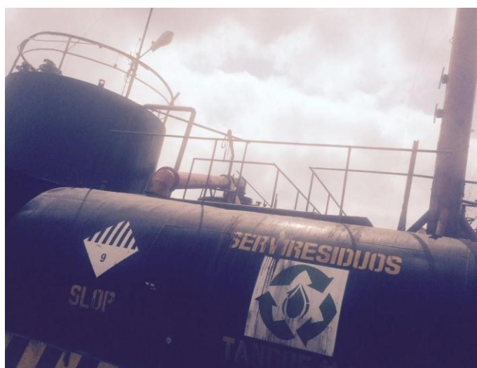
Figura 3.5: Foto que muestra la descarga de vapor generado del destilador hacia los tanques de 15000 galones
