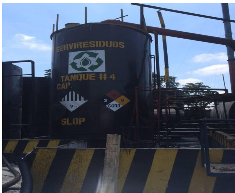
Figura 3.2: Foto que muestra a el tanque destilador que se instaló
