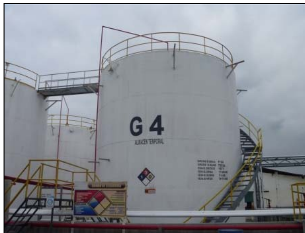
FIGURA 1.2 TANQUE ATMOSFÉRICO VERTICAL
