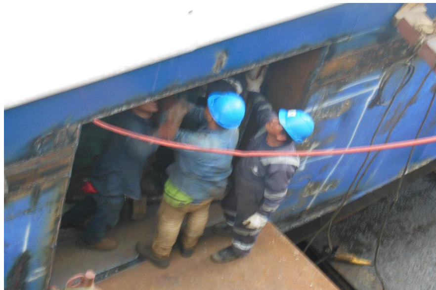
FIGURA 2.3: APERTURA POR DONDE SE SACA EL MOTOR
