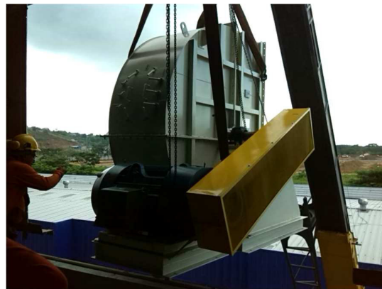
Figura 2.15. Izaje de Ventilador de Gases de Salida
