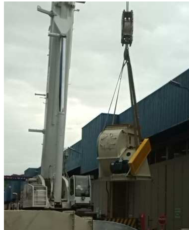
Figura 2.14. Izaje de Ventilador de Transporte de Polvo
