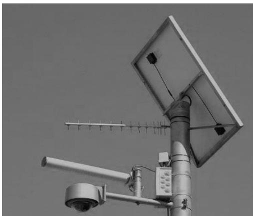
**Figura 2.16: Antena yagi. [12]**
