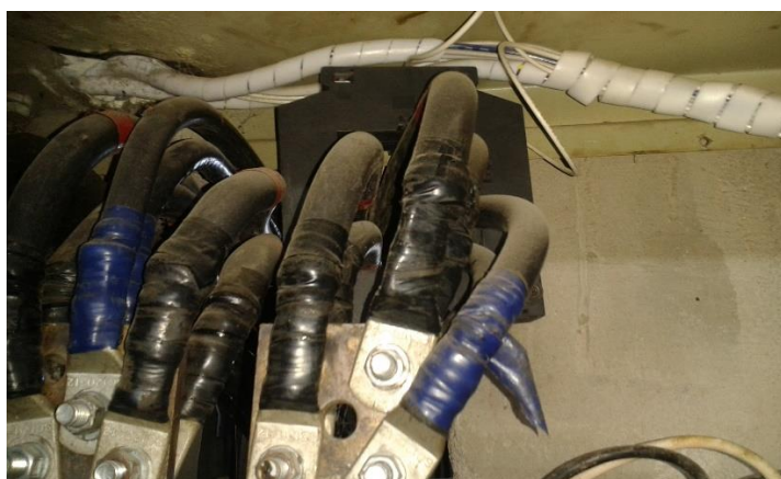
Figura 3.15. Conexión del Transformador de Corriente (TC)
