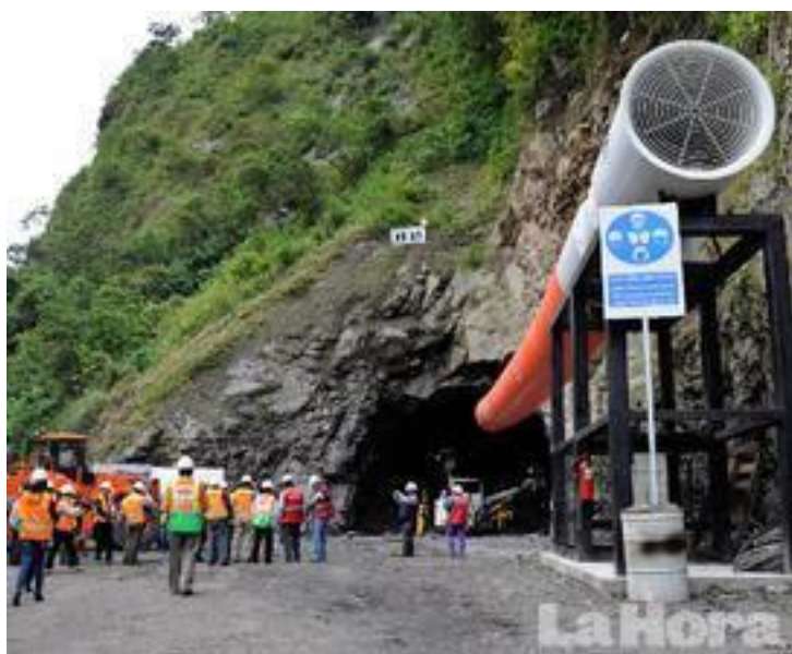
Figura 3.5: Túnel vial en Santo Domingo-Ecuador [37]
