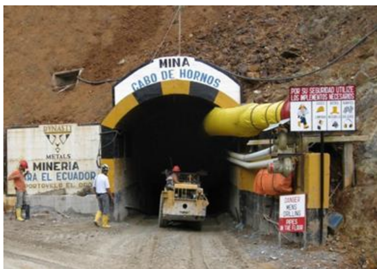
Figura 3.4: Entrada de Mina Cabo de Hornos-Ecuador [36]
