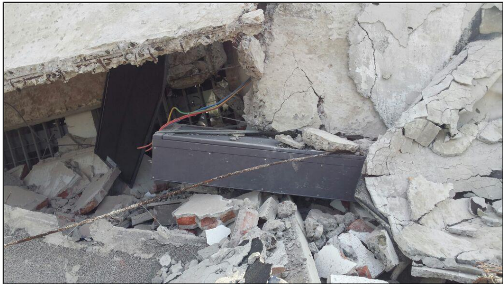
Figura 1.8: Equipos de telecomunicaciones entre escombros, CNT-Jama
