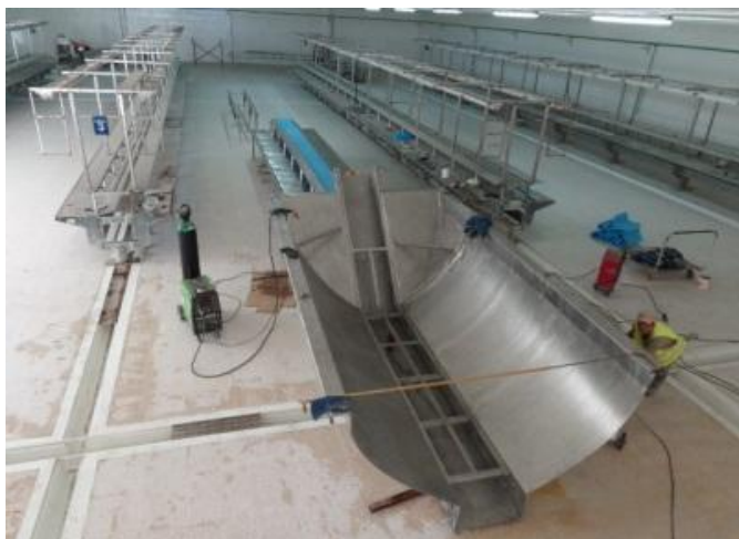
Figura 3.5: Tina de recepción de pesca en construcción
