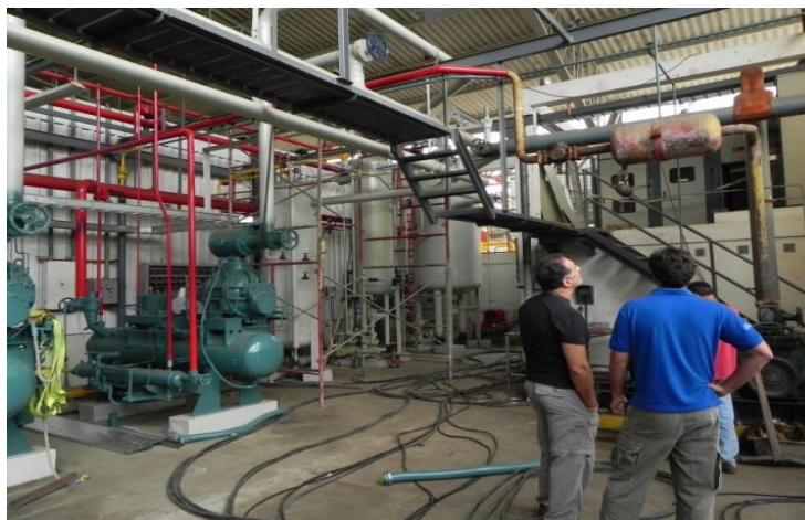
Figura 1.4: Remodelación del cuarto de compresores
