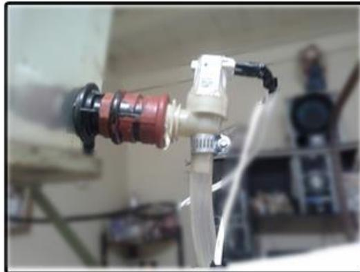
**Figura 3. 3: Electroválvula del sistema de potabilización.**
