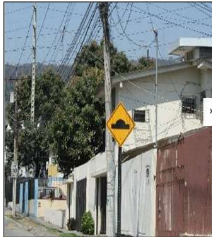
Figura 1.21 Tendido de cables en Av. Primera, Los Ceibos.
