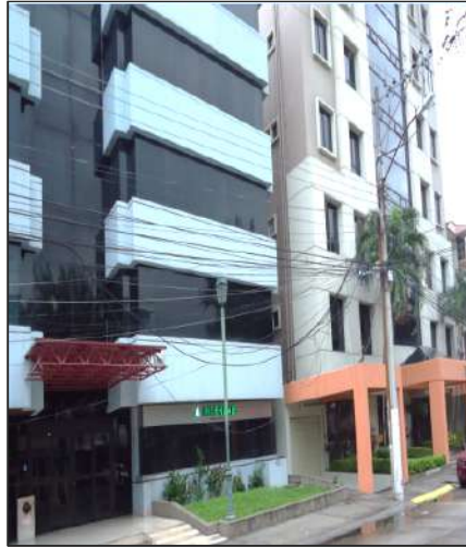
Figura 1.15 Poste ubicado en la ciudadela Nueva Kennedy, Av. Luis Orrantía y calle Nahím Isaías Barquet
