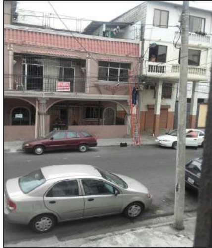
Figura 1.29 Poste ubicado en las calles Maldonado y Guaranda.
