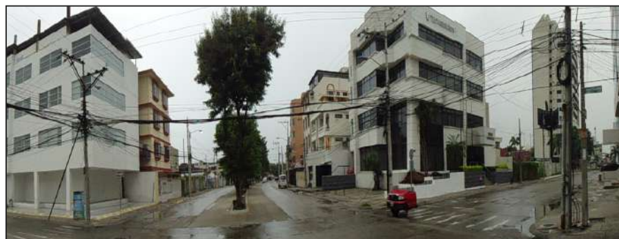
Figura 1.36 Tendido de cables en sector Nueva Kennedy, Av. Luis Orrantía y calle Nahím Isaías
