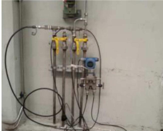
Foto 1. Sensor para la medición presión diferencial en la caja espiral – WK
