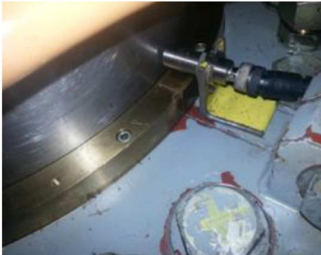
Foto 6. Sensor medición vibración relativa en cojinete guía de la turbina –
