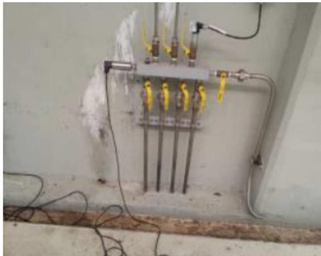
Foto 2. Sensor de presión en la entrada de la caja espiral
