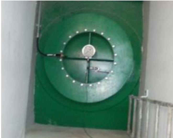
Foto 5. Sensor de presión en el manhole de la caja espiral
