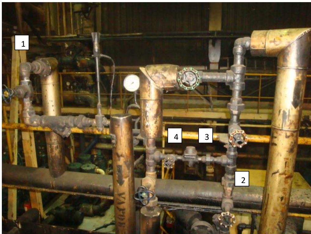
Figura 2.6 Suministro de entrada/salida tanque diario
