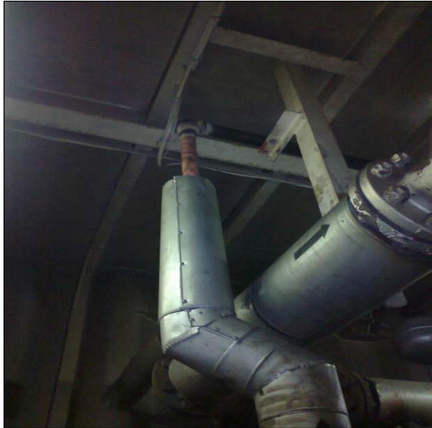
Figura 2.13 Líneas de salida desde el intercambiador hacia el sistema
