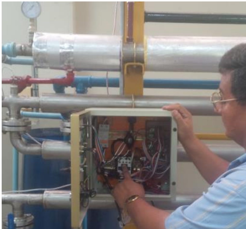
Gráfico 13. Instalación de bomba y sistema eléctrico.
