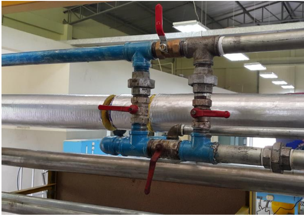
Gráfico 11. Instalación de líneas de alimentación y accesorios.
