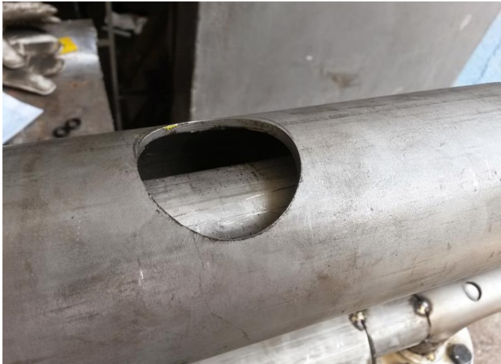
Gráfico 8. Soldadura / montaje de tubos de acero.
