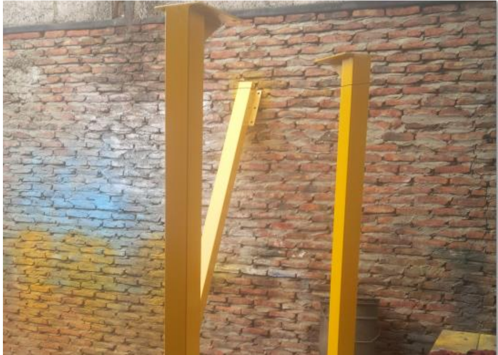
Gráfico 9. Construcción de estructura.
