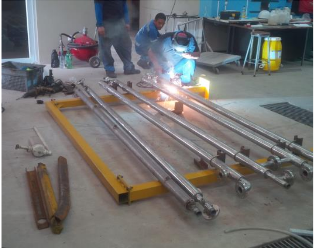
Gráfico 10. Instalación de tubos en estructura.
