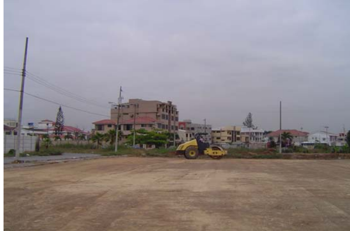
Figura No 4.3 Compactado y Nivelación
