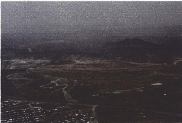
Ilustración 3.1 Relleno Sanitario "Las Iguanas"
