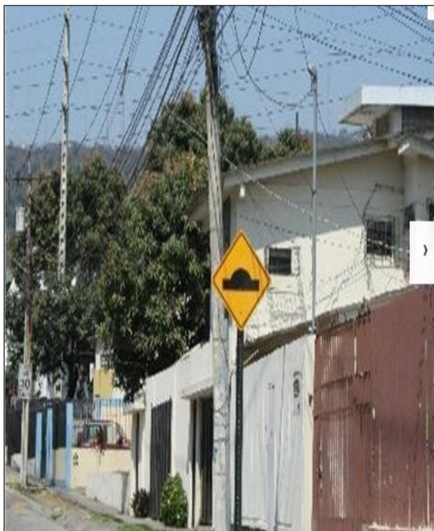
Figura 1.21 Tendido de cables en Av. Primera, Los Ceibos.
