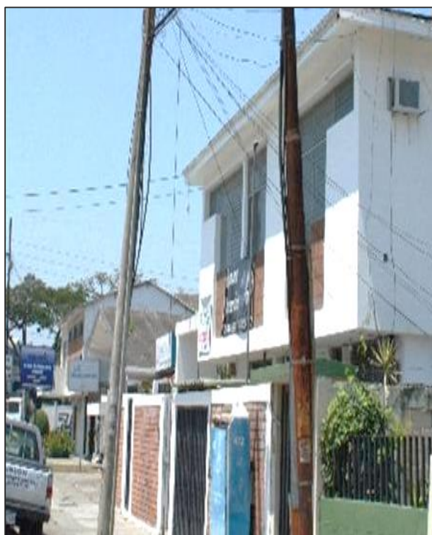
Figura 1.18 Poste ubicado en la av. Francisco Boloña Diario El Universo, Jueves, 6 de octubre 2011
