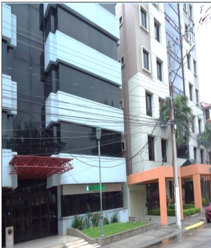
Figura 1.15 Poste ubicado en la ciudadela Nueva Kennedy, Av. Luis Orrantia y calle Nahim Isaías Barquet
