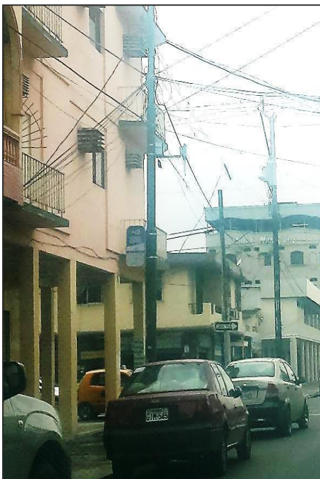
Figura 1.25 Equipo instalado en poste, Calles Guaranda y Cuenca.
