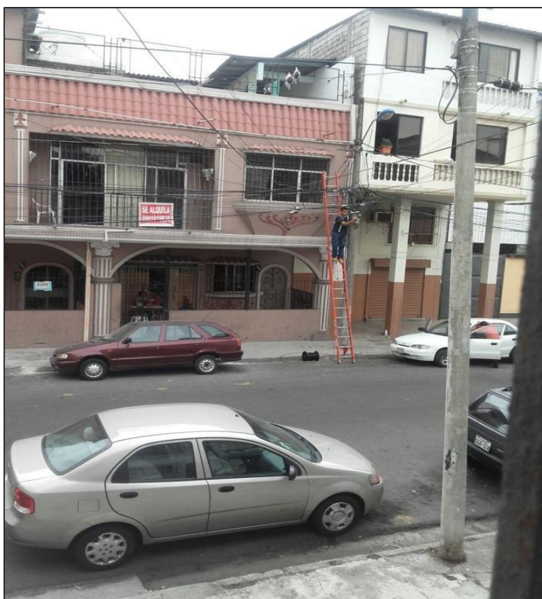
Figura 1.29 Poste ubicado en las calles Maldonado y Guaranda.
