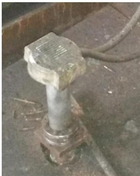
Figura 2.11: Sensor de oxígeno sobre la chimenea.
