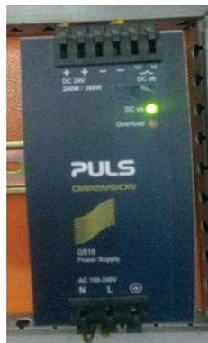
Figura 2.8: Fuente de alimentación que energiza la estación remota.
