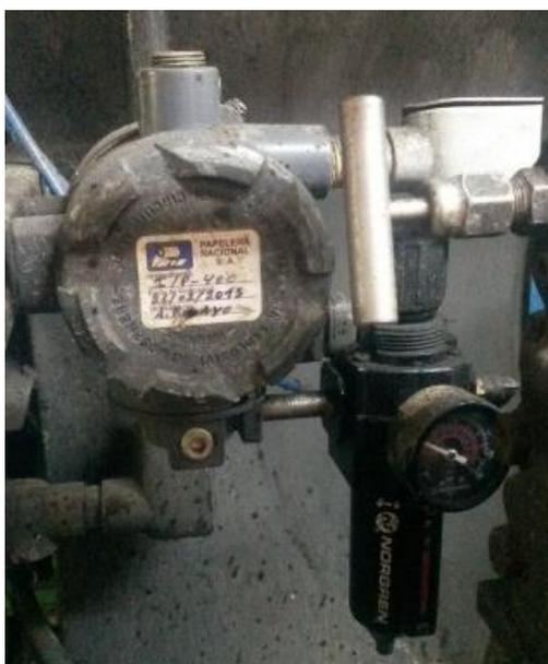
Figura 2.15: Convertidor de corriente a presión.
