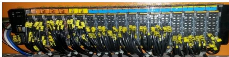
Figura 2.7: Estación remota y Módulos de E/S analógicas y digitales.
