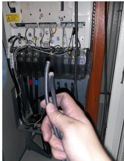
Figura C.2: Trabajo en planta, cableado desde la estación remota al variador de frecuencia.
