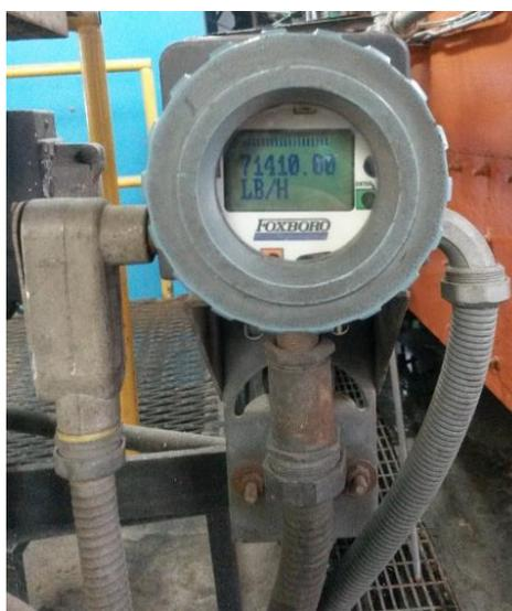
Figura 2.13: Transmisor de flujo de vapor.
