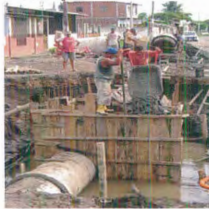
Foto 2.19 Trabajo de Alcantarillado
