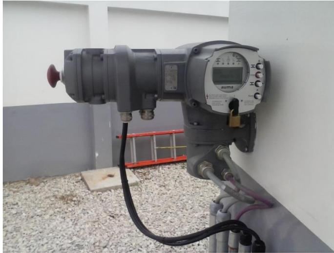
*Figura 1.2: Actuador Eléctrico Auma*
