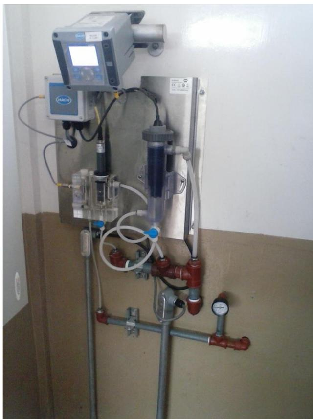
*Figura 1.1: Sistema de medición de cloro residual*
