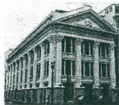
Edificio Diario El Universo
