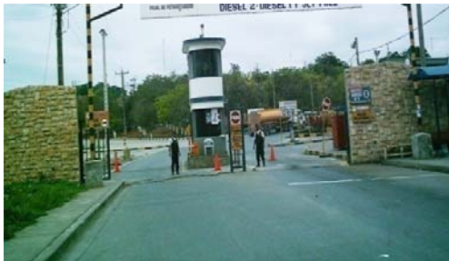
GARITA No. 1. ENTRADA A LA PLANTA
