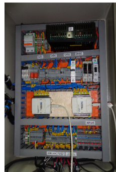
Figura 4.4: Panel de control alimentación de sensores y tarjetas de adquisición de datos.
